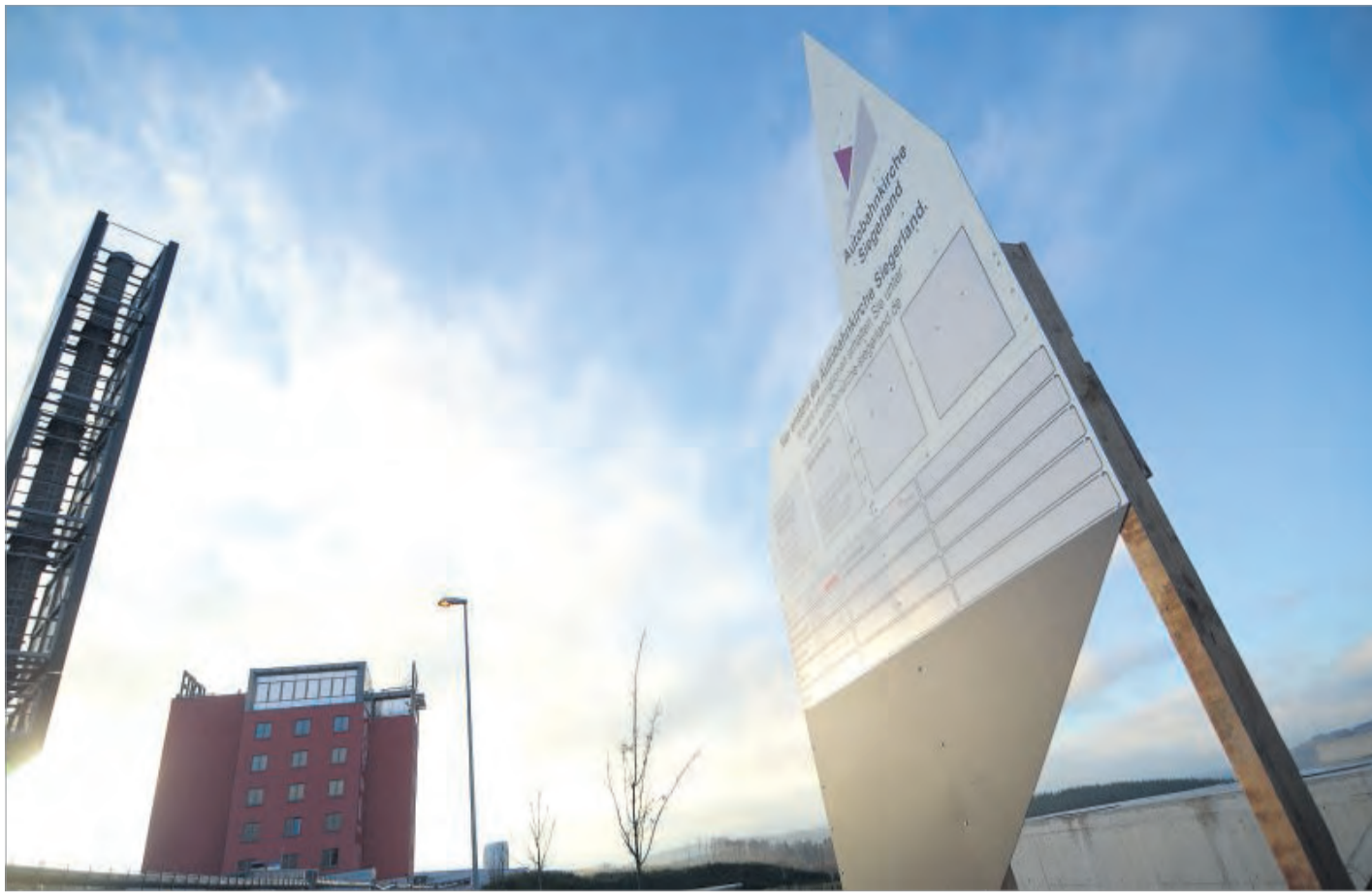
Seit Juli ruhen die Bauarbeiten an der Autobahnkirche. Das Sockelgeschoss steht, jetzt wurde ein Schild aufgestellt. Foto: dima
